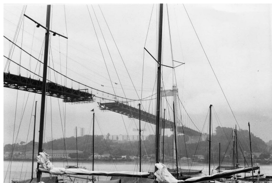
Illustration 1: Construction du Pont d'Aquitaine
