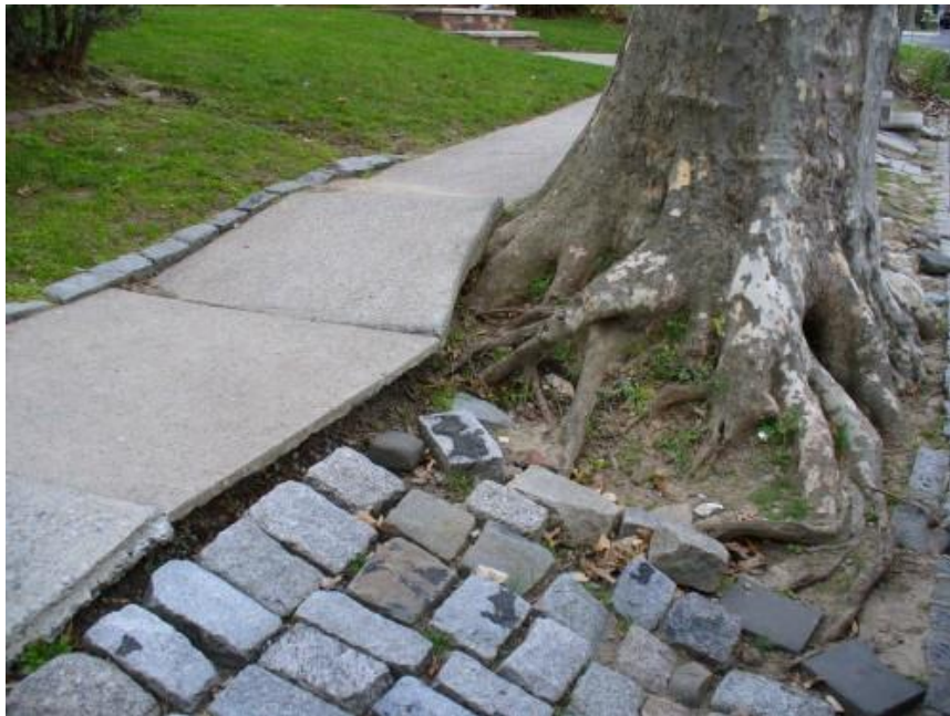
Figure 8 : Dégâts causés par les racines, Source : CLCtreeservices
